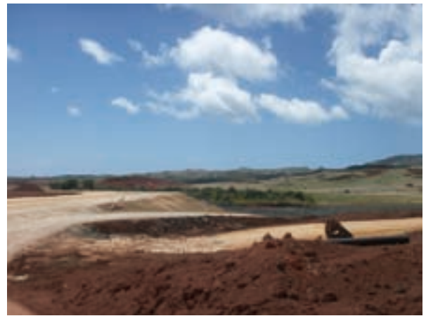
造成が進む新廃棄物処理場
