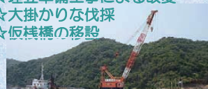
(6月13日、仮棧橋の土台を移設するクレーン船)
