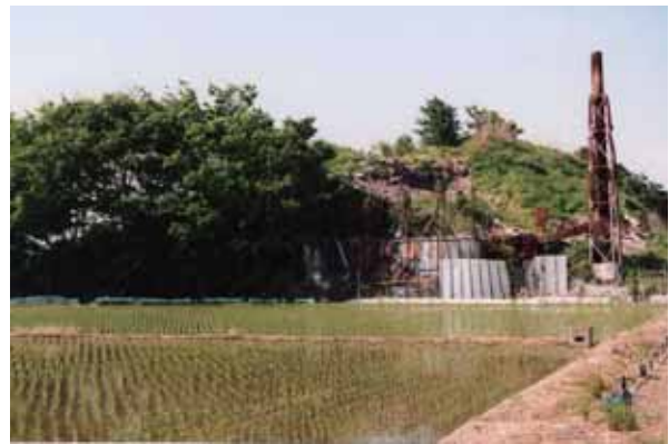
杉戸町倉松（体積概算10,000m 3 ） 周辺は水田、住宅に近いゴミ山だが、700mg/kgの鉛が検出されている。
