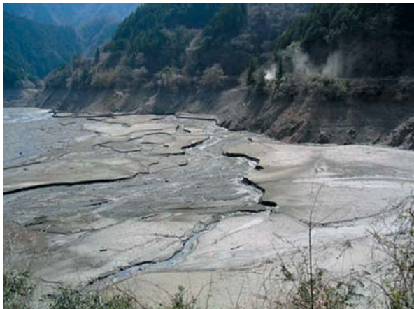
写真3 水窪ダムの堆砂（2004年3月29日） 水窪湖ダムサイト上流1.6km地点。このあたりから粘土状の堆砂が始まる。
