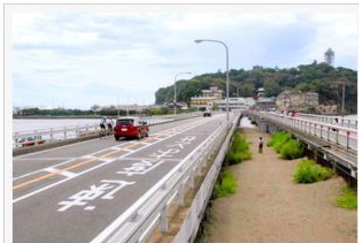
道路の拡幅が予定されている江の島大橋（左）＝藤沢市で
