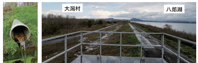
図1 左:堤防の大潟村側で湧出している八郎湖水。大潟村では堤防沿い約1 km長で堤防からの湧水を集め、ポンプを使って、地下に埋設した水管を通じ浄水場まで送水している。右:八郎湖と大潟村。八郎湖の水面は大潟村の標高よりも高い。
